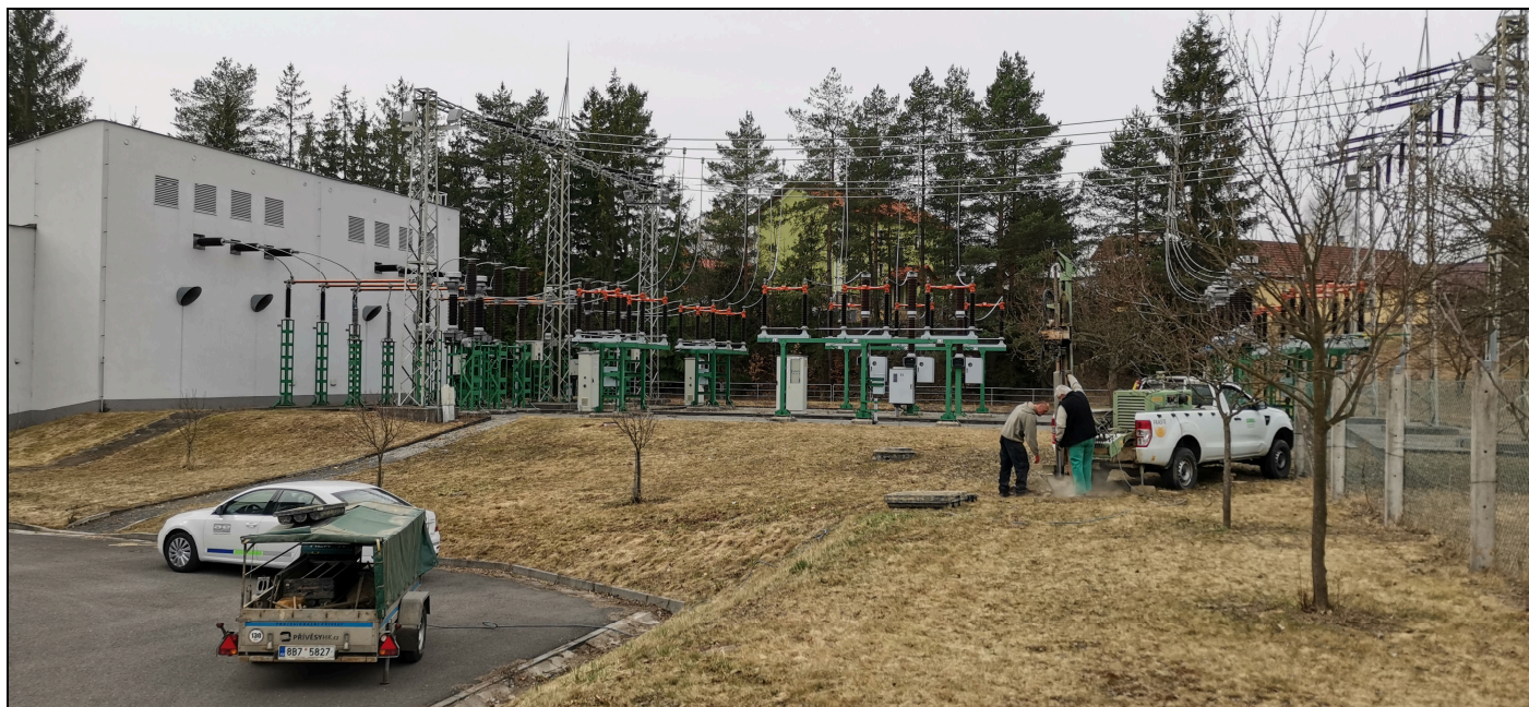
Obr.1: Realizace vrtu IJ3 soupravou Multidrill Hyndaga dne 29.3.2022
